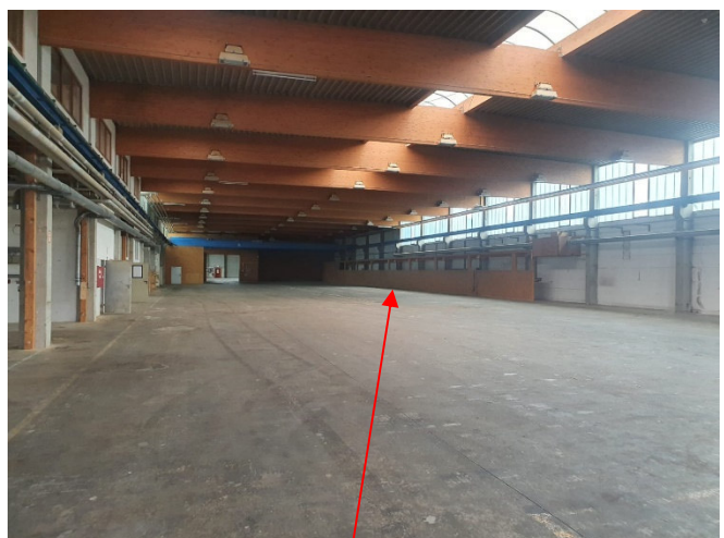
Bild 6: Blick von Westen in die südliche Längshalle; Lage der Bohrungen RKS / DPH 5
