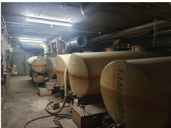
Bild 5: Blick in Innere des Kellers
