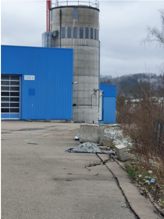
Bild 7: Blick nach Südosten zum Spänesilo im Bestand westlichen Parkflächen im Bestand; abfallendes Gelände nach Südosten im Bereich geplanter Verkehrsflächen
